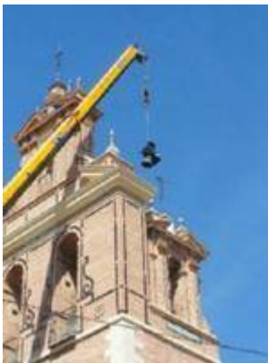
Colocación de una campana en la espadaña de la iglesia de San Juan de la Palma
