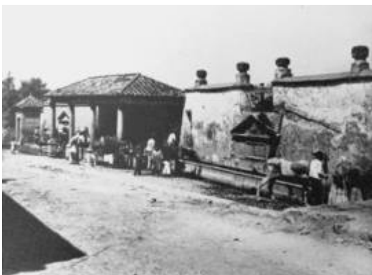
Old fountain of Fuente Nueva -2- (in Camino de la Fuente Nueva street)
