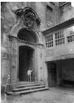
Colegio de los Meninos Órfãos (patio interior). Fotografía de José Arthur Leitão Bácia
