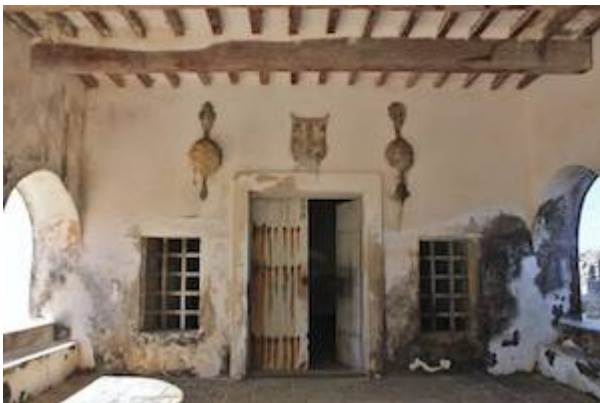
Capilla de Nossa Senhora do Baluarte (fachada)
