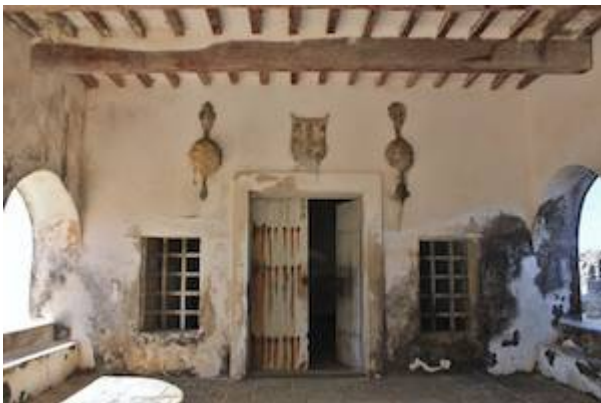
Capilla de Nossa Senhora do Baluarte (fachada)
