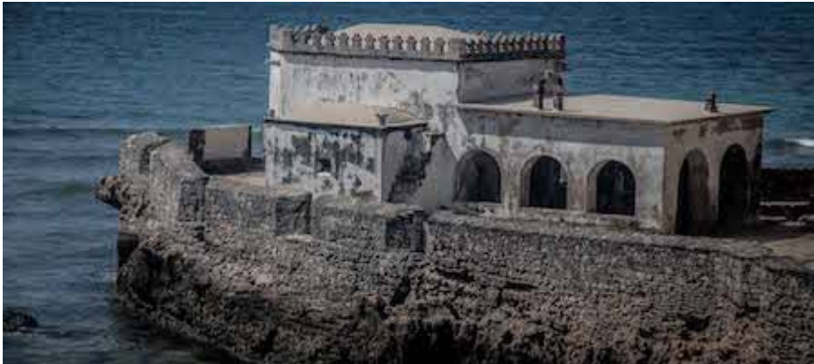
Capilla de Nossa Senhora do Baluarte
