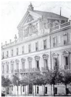
Puerta principal del palacio de Medinaceli
