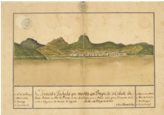
Elevação e Fachada que mostra em Prospecto a cidade de Santo Antonio na Ilha do Principe (...). José António Caldas (1757)
