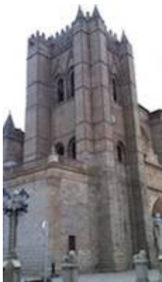
torre de la catedral de Ávila. Fotografía: A. de Vicente
