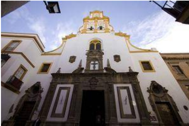
Convento del Espíritu Santo (actual iglesia de Santa Cruz). Fotografía de Gpedro
