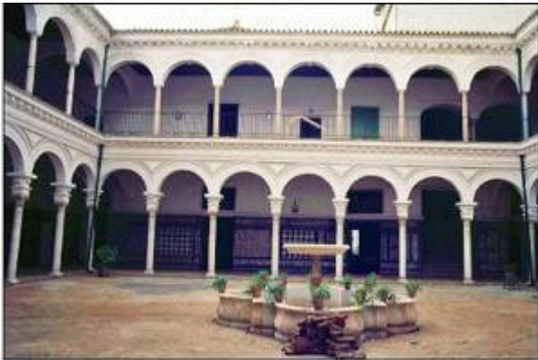
Convento de Santa Paula. Descripción del edificio y algunos datos históricos
