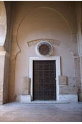
Nave del Lagarto. Fotografía de José Becerra
