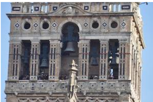
La Giralda (detalle)
