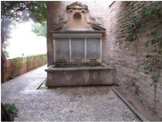
Pilar fachada (1628). Jardín del Adarve. Fotografía de Kolforn
