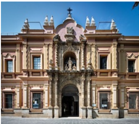
Fachada del convento de la Merced
